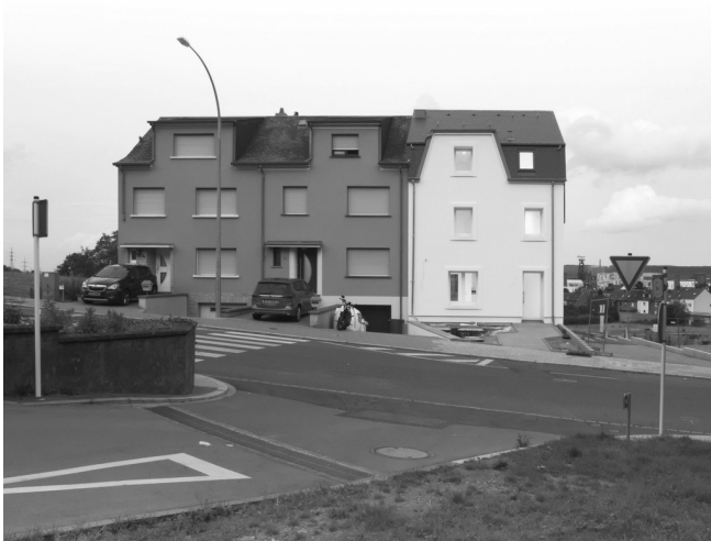
Die „Maison témoin 2020“ wird als Sozialwohnung vermietet werden.
