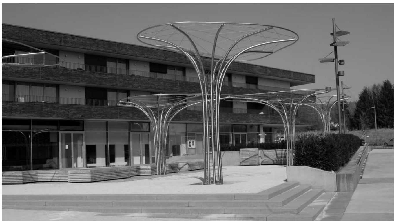
Das neue gemeindeeigene Altenheim REWA „Résidence Op der Waassertrap“ in Beles.
