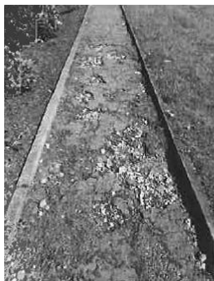
Aktueller Zustand vor Renovierung
