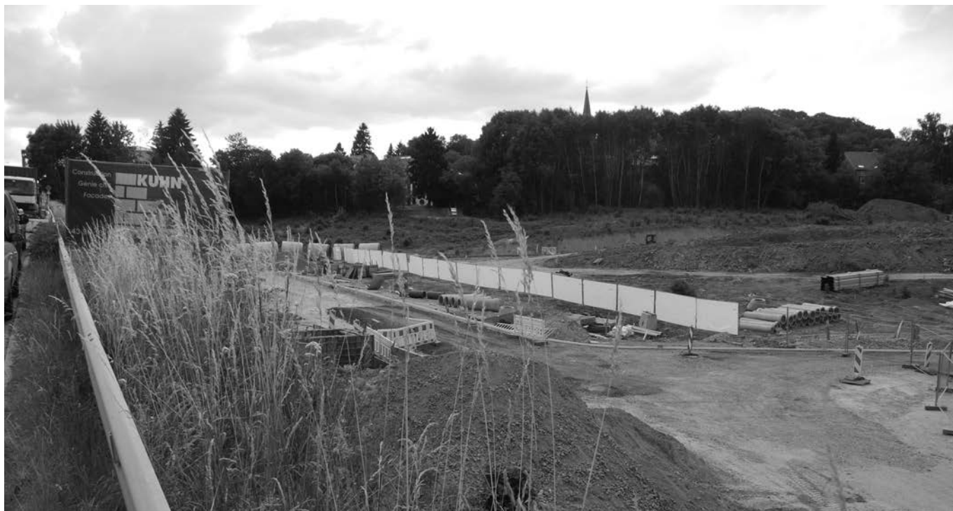
In Zolwer entsteht hier eine neue Wohnsiedlung.
