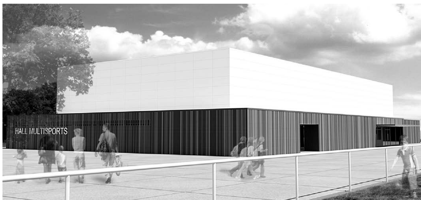
So könnte die neue Sporthalle in Sanem aussehen.
