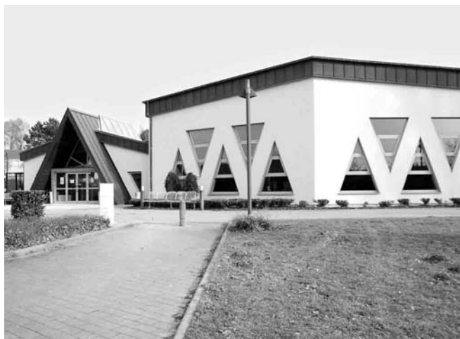
Eine neue Heizung für die Halle in Sanem
