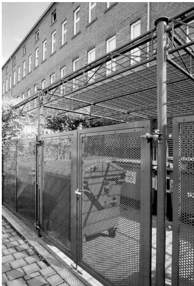
Die „Schoul 2000“ in Zolver bekommt neue zweckmäßige Waschbecken und einen Stahlkäfig für die Mülltonnen im Schulhof
