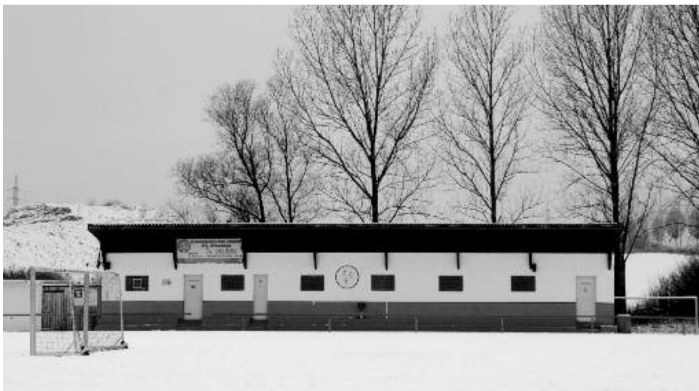
Baufällige Umkleidekabinen des Ehleringer Fußball werden neu errichtet.
