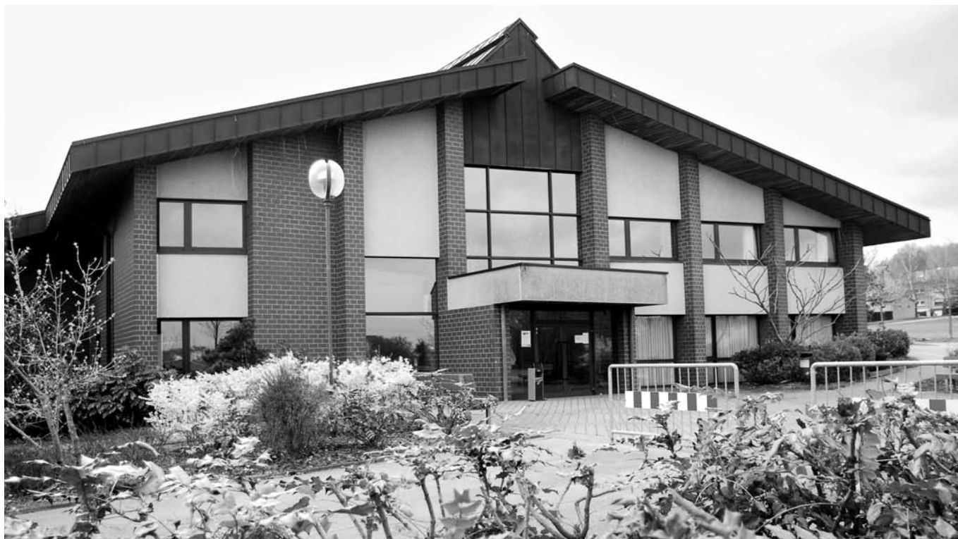
Das Gesims des Kulturzentrum im Metzerlach wird erneuert
