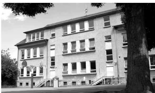
Die „alte“ Schule in Sanem wird weiter renoviert und durch einen Anbau vergrößert
