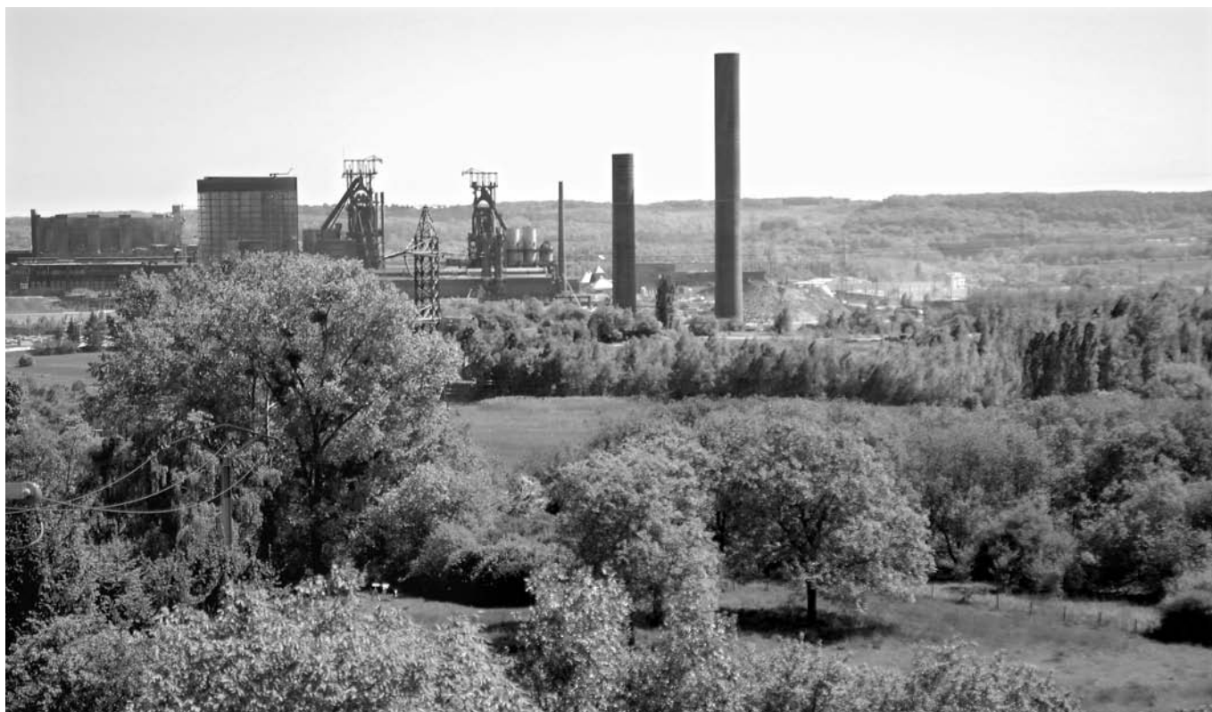
Die Schornsteine auf Belval werden auf 40 Meter verkürzt
